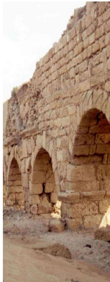
3. Aqueduct, Caesarea // קיסריה, אמות המים // قناة الماء بفسارية
